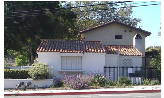
Estación Elevadora de Braemar
